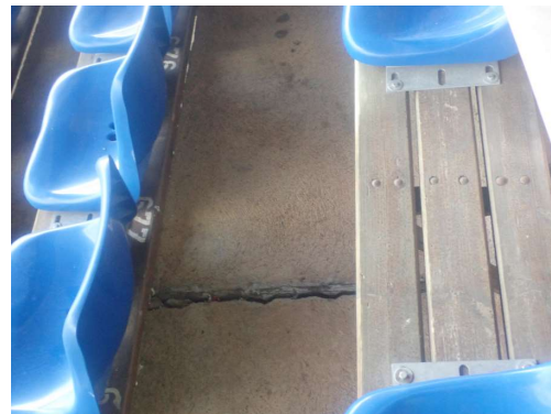
Kuvat 25 ja 26. Katsomossa olevat liikuntasaumamat ovat huonokuntoisia.
