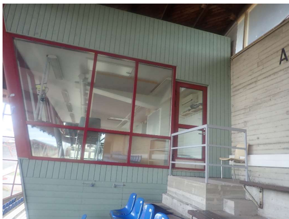
Kuva 22. Katsomon toisessa päädyssä olevassa isomman kopin puuosa olivat ulkopuolisten havaintojen perusteella hyväkuntoisia.
