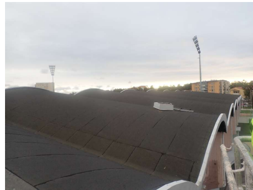
Kuvat 23 ja 24. Katsomon katteessa ei havaittu puutteita silmämääräisellä tarkastelulla.
