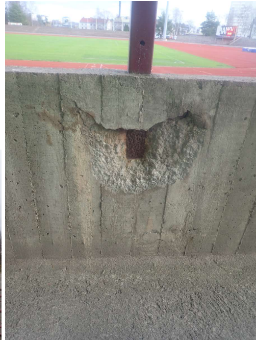
Kuvat 6 ja 7. Kuvassa 6 kaiteen paikkaus vaurioitunut, kuvassa 7 kaiteen betonirakenteen lohkeama kaiteen katsomon puolella (sisäpuolella).
