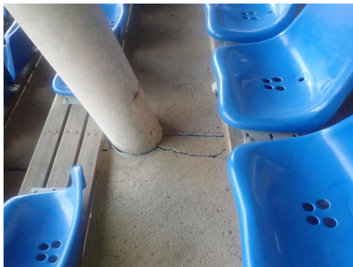
Kuvat 25 ja 26. Katsomossa olevat liikuntasaumamat ovat huonokuntoisia.
