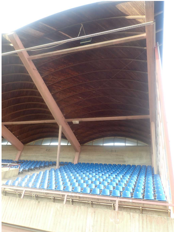
Kuva 18. Katsomon katon kaaret on tehty puurakenteisena.
