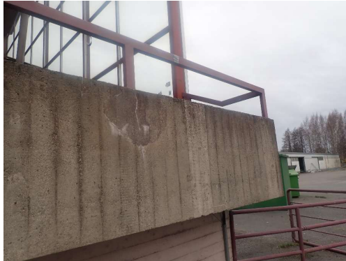
Kuvat 6 ja 7. Kuvassa 6 kaiteen paikkaus vaurioitunut, kuvassa 7 kaiteen betonirakenteen lohkeama kaiteen katsomon puolella (sisäpuolella).
